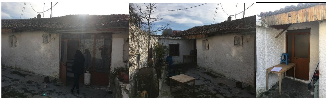
Figura 93. A. Përdorimi i vetratave të aluminit të ftohtë; B. Oborri i brendshëm i banesës; C. Përdorimi i dyerve të aluminit të ftohtë (Banesat historike, burimi: K. Xhexhi).
