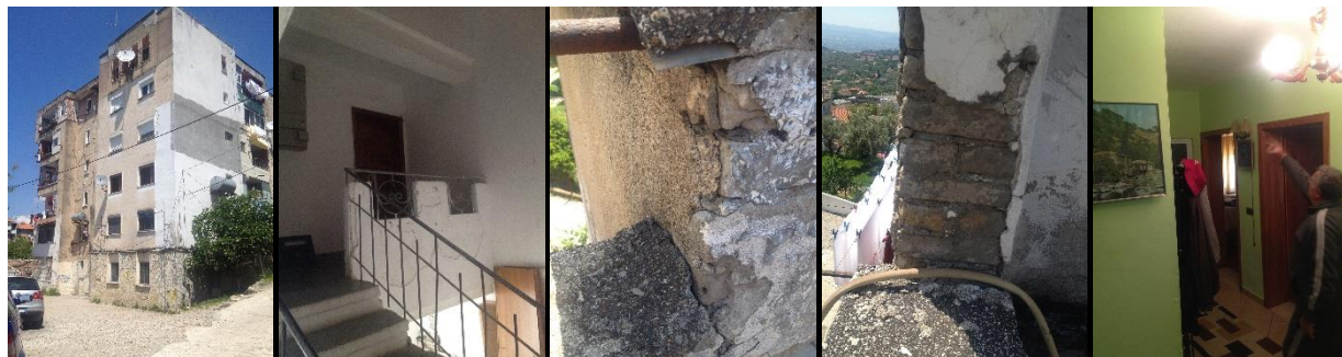
Figura 94. A. Pamje e godinës socialiste; B. Struktura e kafazit të shkallës; C. Përbërja e muraturës; D. Përbërja e muraturës; E. Moment interiori; (Banesat socialiste, Burimi: K. Xhexhi)
