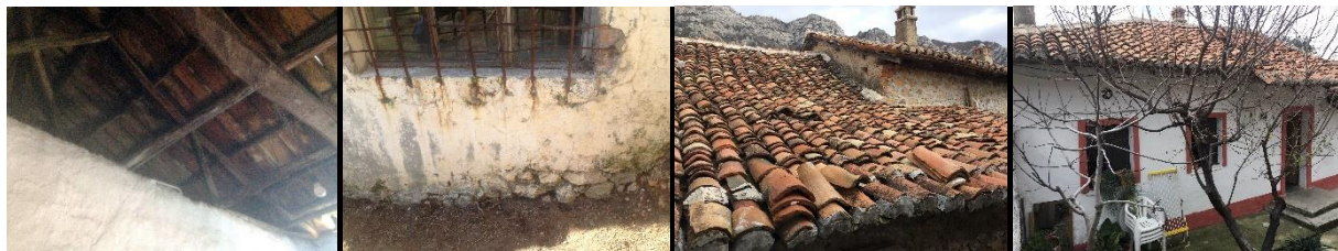
Figura 90. A. Detaj çatie; B. Kontakti i katit përdhe me terrenin; C. Mbulimi i strukturës së çatisë me tjegulla të lugëta; D. Shtesë trotuari betoni për mbrojtjen nga lagështia (Banesat historike; burimi: K. Xhexhi)
