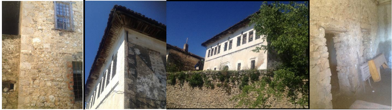
Figura 91. A. Trajtimi i qosheve me gurë të zgjedhur; B. Detaj qosheje dhe mbyllje çatie; C. Fasada kryesore; D. Pozicionimi i brezave të drurit në muraturë (Banesat historike, burimi: K. Xhexhi)
